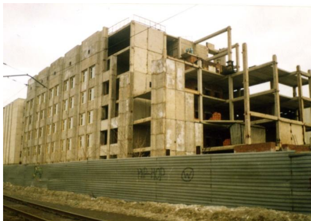
2002 г. Процесс строительства в разгаре
